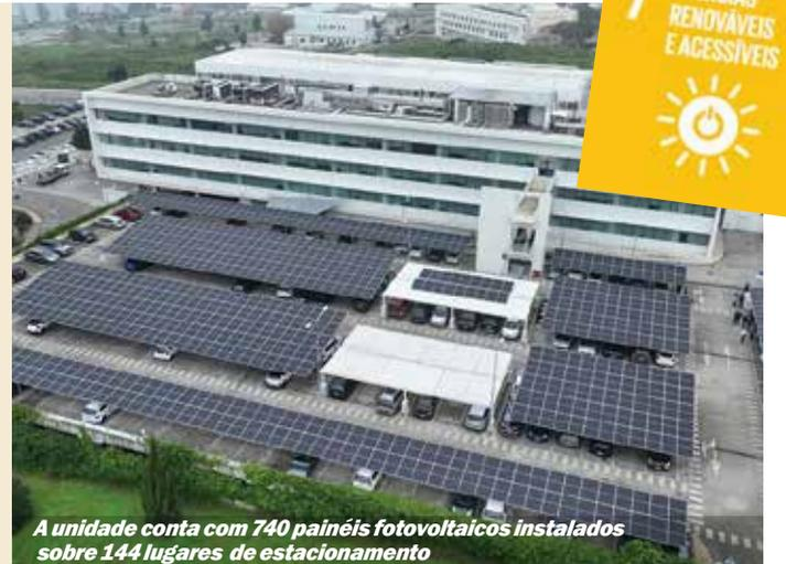
A unidade conta com 740 painéis fotovoltaicos instalados sobre 144 lugares de estacionamento
