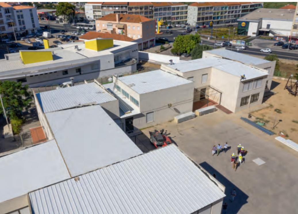
A Câmara Municipal do Seixal procedeu à remoção das coberturas em fibrocimento em 12 escolas do concelho do 1.º ciclo do ensino básico e colocou novas coberturas de painéis *sandwich* com isolamento térmico.
